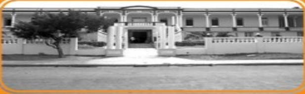
Frente del Centro Gallego (actualmente materno)
